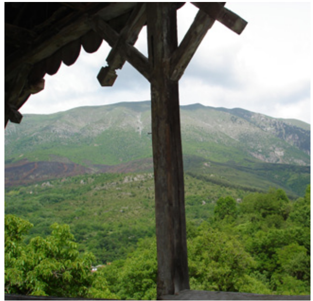
7. Кућа Џинића (Џиновци), детаљ дрвене конструкције чардака, утицај печалбарења
